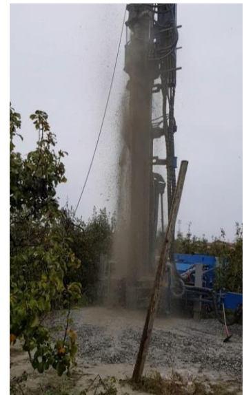
Forage d'un puits à l'emplacement de la future salle multifonction
